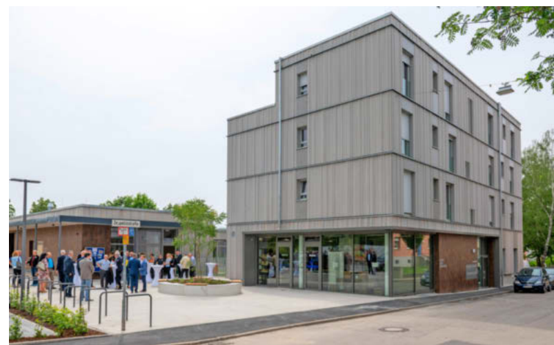
6,2 Millionen Euro hat die Stadtsiedlung in das Bauprojekt investiert. Im großen Neubau sind auch acht Wohnungen entstanden, sechs sind mit vergünstigter Miete.
