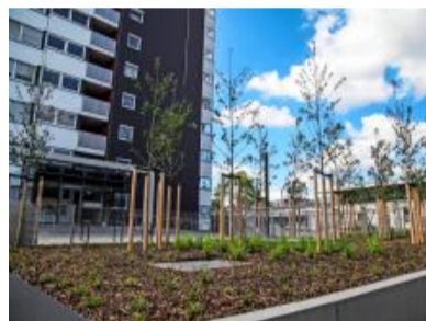
Die 170 Wohnungen in der Werderstraße wurden umfangreich modernisiert.
