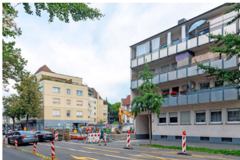
Weststraße 52 heute: Die Baustelle in Bahnhofsnähe ist eingerichtet, die Baugrube ausgehoben. Die Abwicklung an der Baulücke birgt einige Probleme. Foto: Mario Berger
