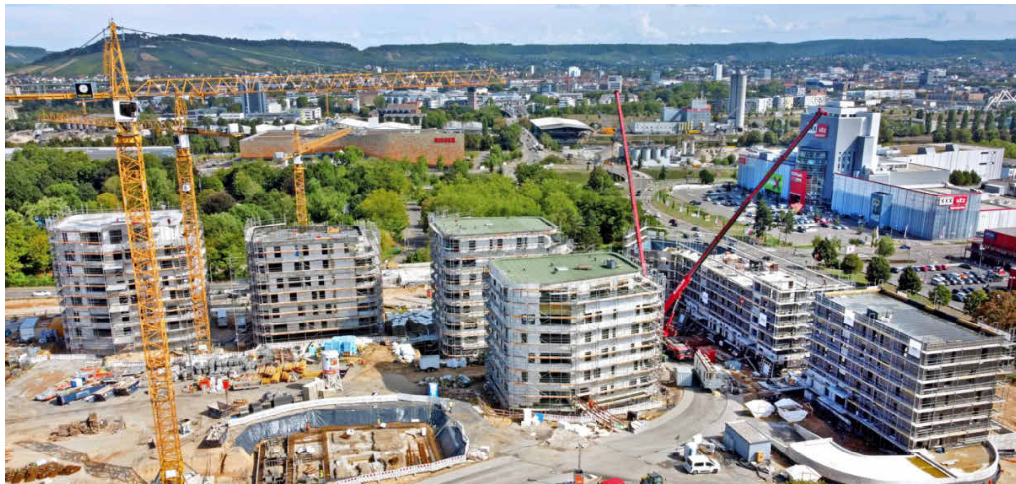
Blick aus der Vogelperspektive auf die Großbaustelle Hochgelegen der Stadtsiedlung Heilbronn. In der Mitte die ersten vier von 14 Punkthäusern, am rechten Bildrand stehen die Riegelhäuser.
