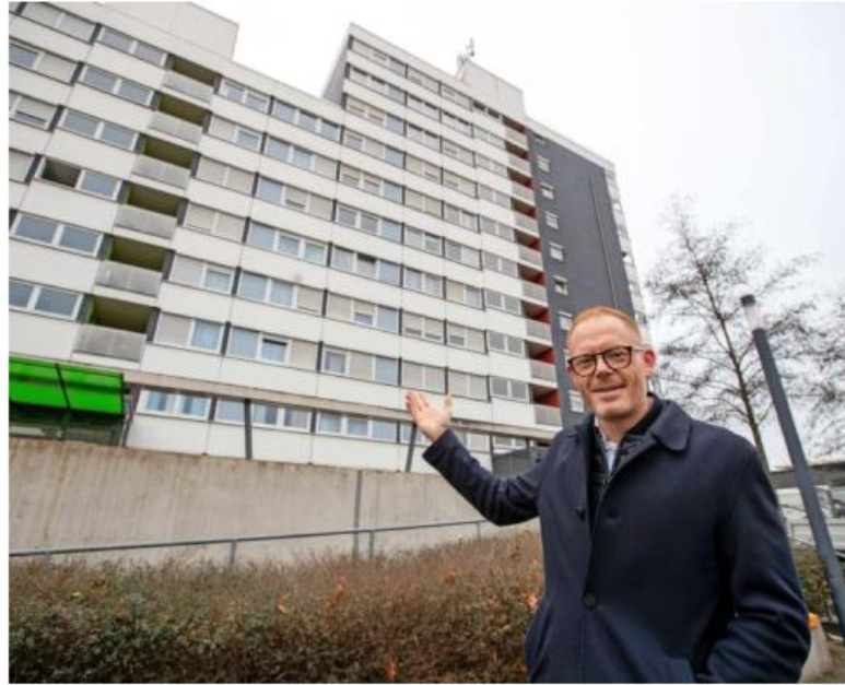
Michael Schanz, Abteilungsleiter Bestandsmanagement, vor einem Haus der Stadtsiedlung, für dessen Mieter schon eine Infoveranstaltung stattfand. Foto: Andreas Veigel
