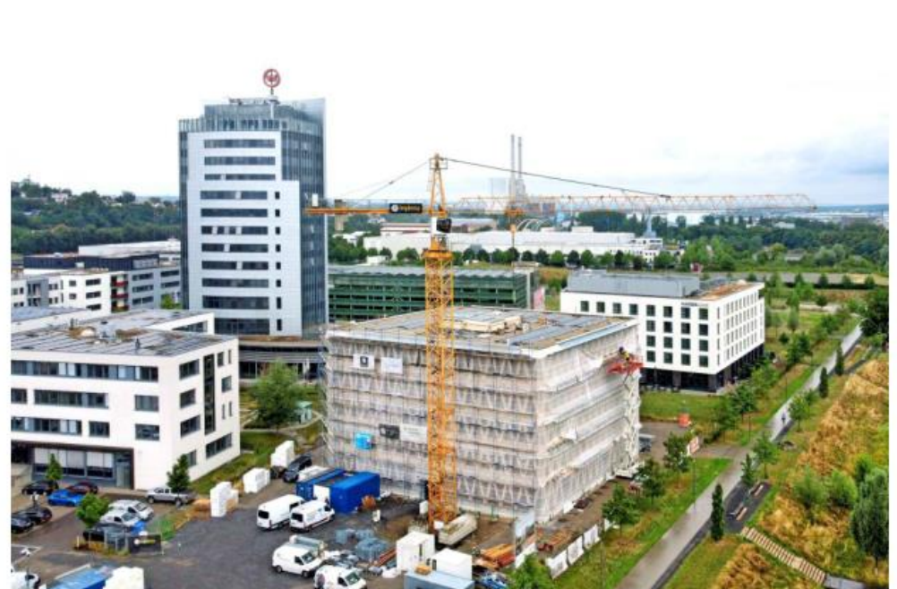
Nach den Plänen der Architekten Waechter + Waechter errichtet die Stadtsiedlung im Zukunftspark Wohlgelegen einen Holz-Hybrid-Neubau. Einziehen wird die Innovationsfabrik 2.0 (IFH). Fotos: Ralf Seidel
