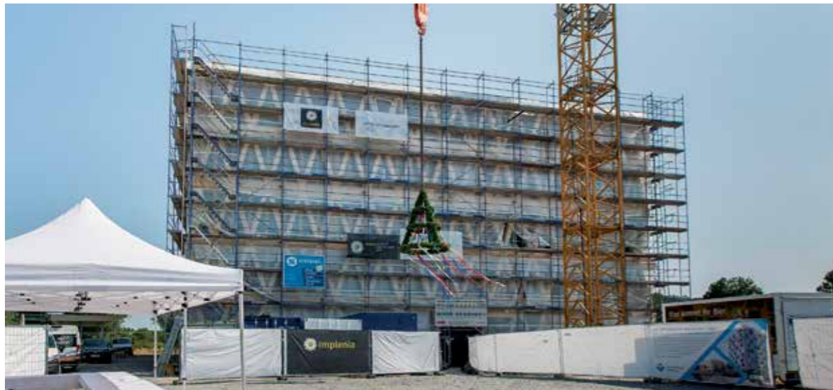
Aktuell ist die gesamte Fassade noch mit Planen abgehängt, deswegen kommt die Besonderheit der Innovationsfabrik 2.0 in Heilbronn vorerst nur im Inneren zum Vorschein. Rundherum verlaufen an der Außenseite v-förmige dicke Holzstreben, die fast wie ein Fachwerkhaus anmuten. Diese auffällige Holzkonstruktion wird – dank vorgelagerter Glasfassade – für den Betrachter voll sichtbar bleiben und zu einem Erkennungsmerkmal für das Gebäude werden.
