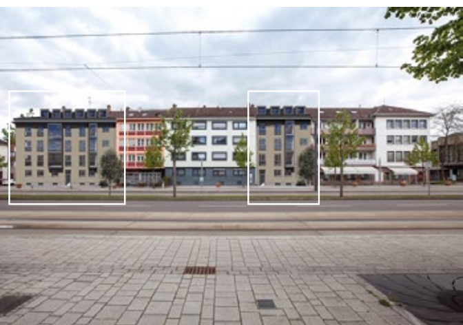
Die Häuser in der Allee sind aus den 1950er-Jahren
