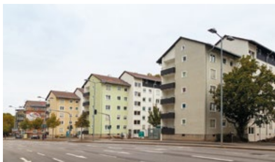
Die Mannheimer Straße im neuen Look
