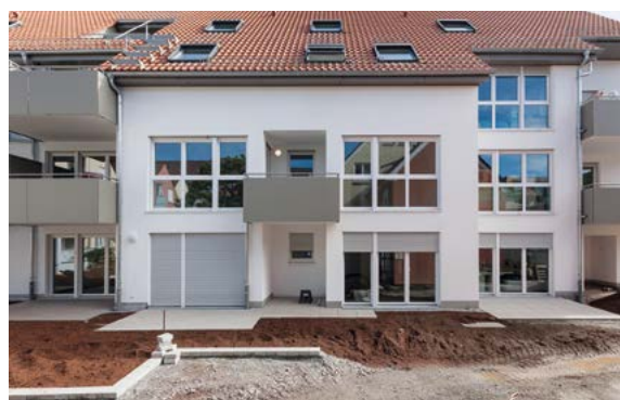
Der Neubau mit 18 Wohnungen wurde im Sommer fertiggestellt
