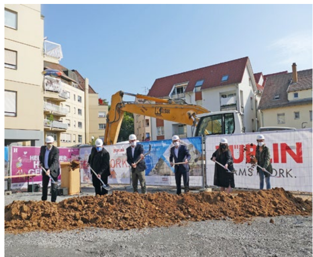
Spatenstich mit Vertretern der Stadt, der Stadtsiedlung, des Generalunternehmers und der Architekten
