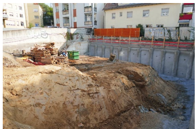
Der Blick auf die Baustelle zeigt die beengten Platzverhältnisse
