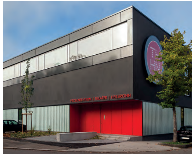
Der Neubau der Probenbühnen in der Christophstraße
