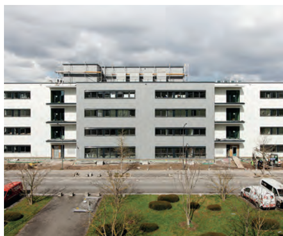
Im Zukunftspark können in den nächsten Jahren weitere Bauvorhaben realisiert werden
