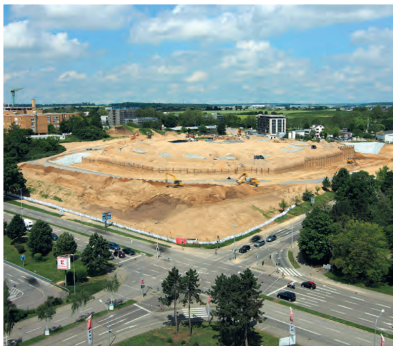
Hier entsteht das neue Stadtquartier
