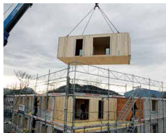
Die im Werk vorgefertigten Module werden vor Ort „gestapelt“
