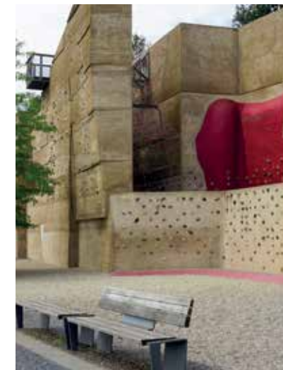
Der Spiel- und Kletterbereich „Felsenufer“ entstand zur BuGa an einer Lärmschutzwand. Doppelt clever!
