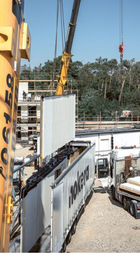
Lkws bringen die fertigen Module auf die Baustelle nach Heilbronn.
