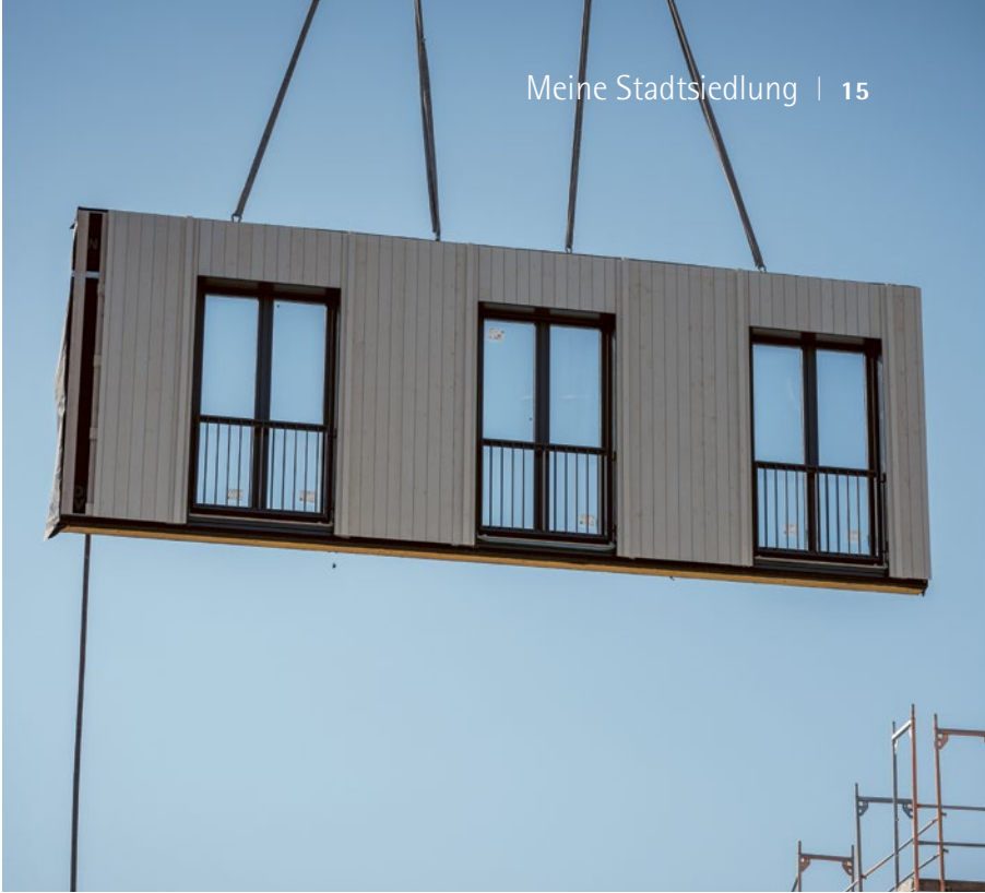
Dort werden sie von Kränen an Ort und Stelle gehoben.
